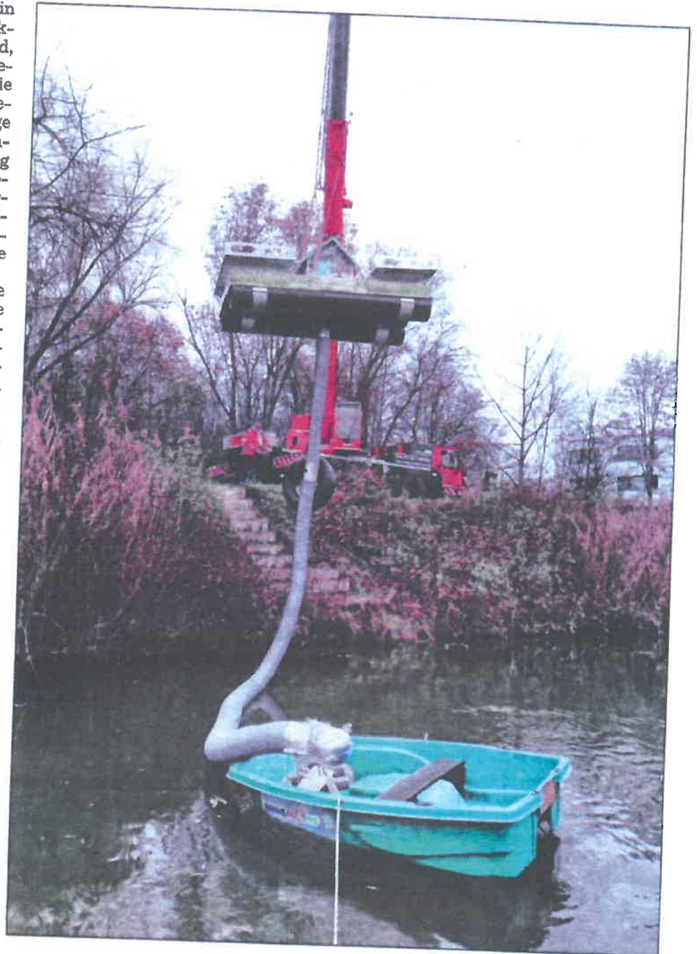
Eine schwimmende Insel voller Technik bläst Luft auf den Seegrund.
